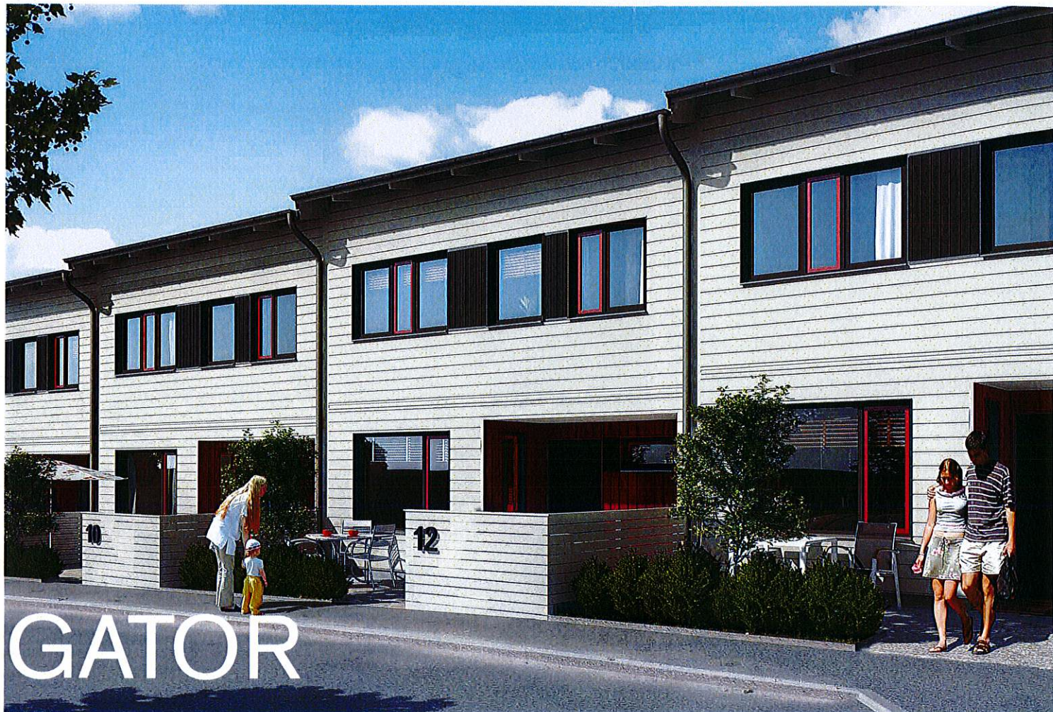
Staket och häckar som avgränsar förgårdsmarken från gatan samspelar med husen. Exempel från JM, Järvastaden.
