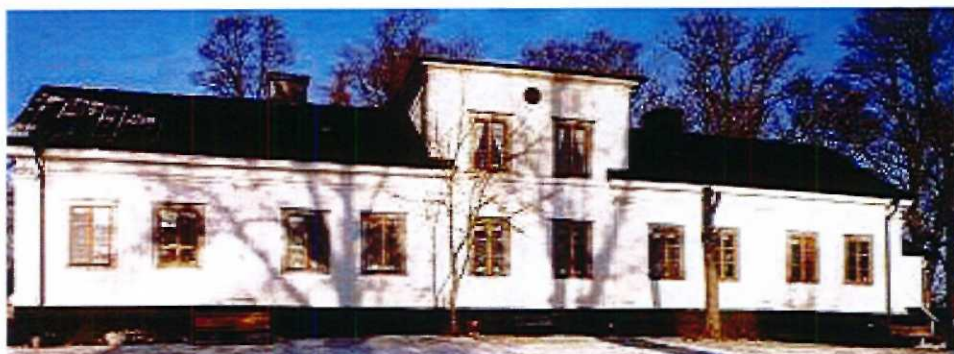
Herrgårdsbyggnaden på Smedby
