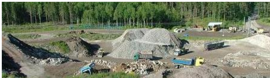
Fig. 1.1.1. Deponering och återvinningsverksamhet vid Ullnatippen.
