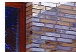
Fönster placeras en bit in i fasadlivet
