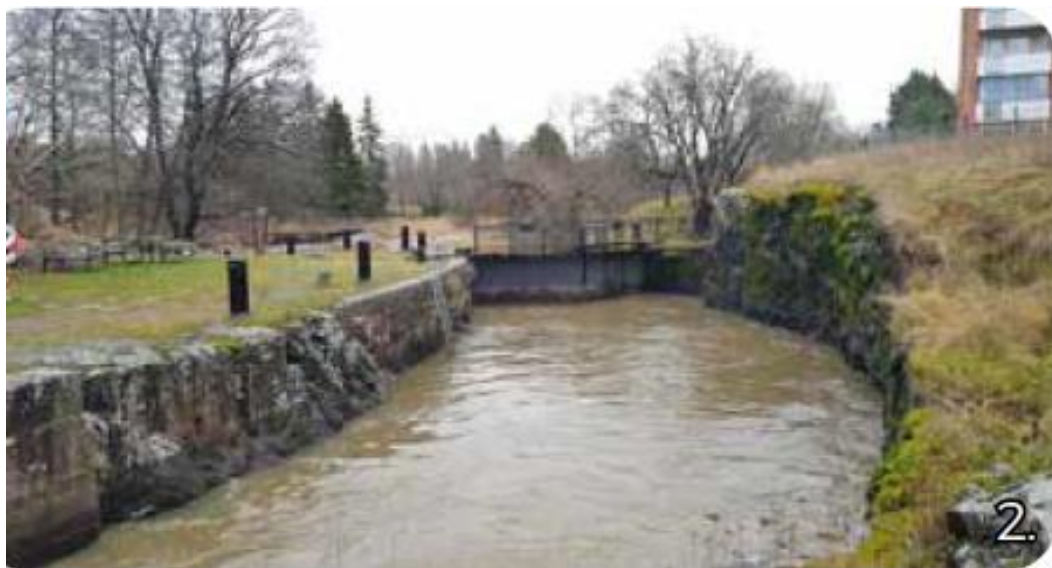
Figur 7. Slussanläggningen (Siffran 2 i Figur 5). ( Slussholmen Antikvarisk utredning och konsekvensanalys )
