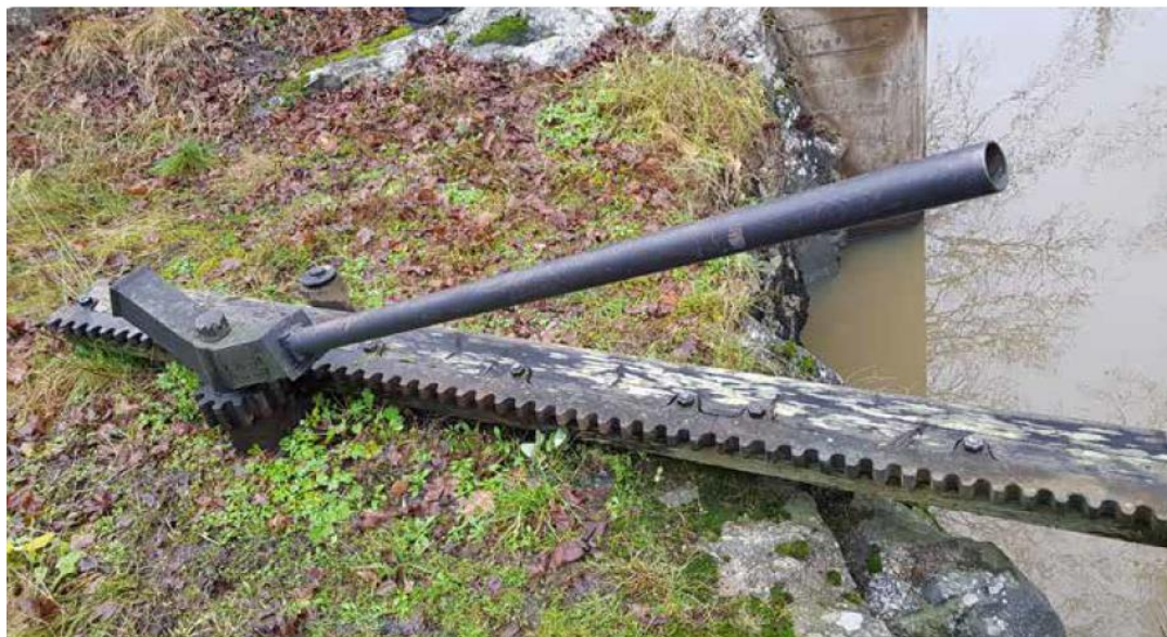
Figur 8. Visar hävarmen som hjälper till att öppna slussportarna. ( Slussholmen Antikvarisk utredning och konsekvensanalys )
