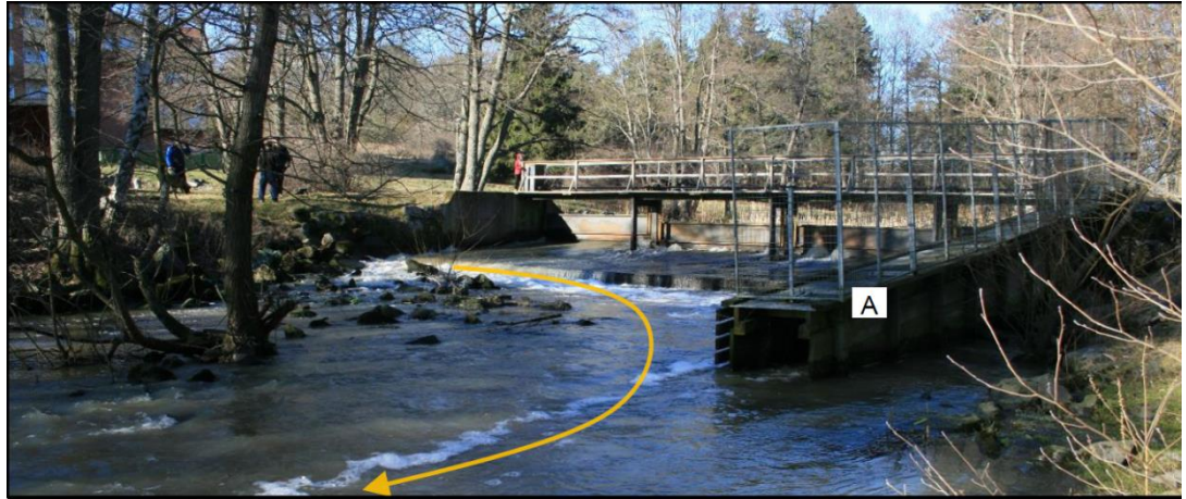
Figur 23. Befintligt dämme med nuvarande fiskväg (A). Fotografi upp mot dämnet från kanalens östra strand i riktning mot Slussholmen. Den dominerande strömfåran markerad med gul pil.
