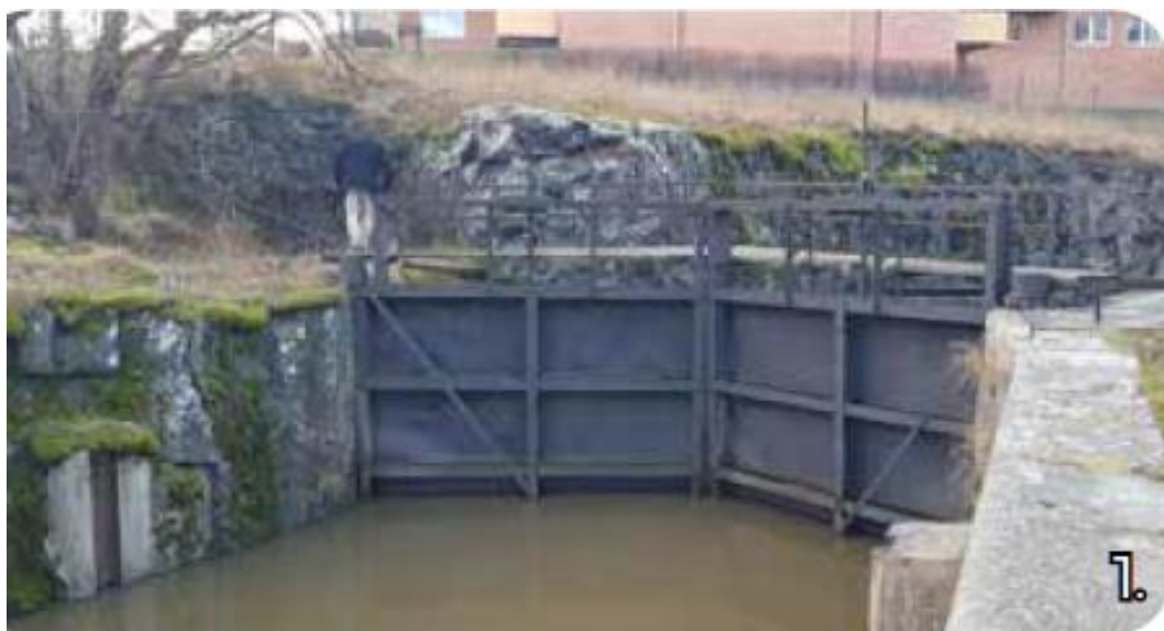
Figur 6. Slussanläggningen (Siffran 1 i Figur 5). ( Slussholmen Antikvarisk utredning och konsekvensanalys )
