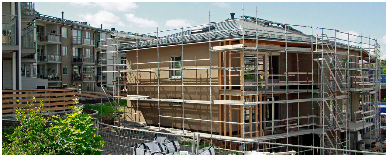
Byggnation vid Bergavägen i Åkersberga.
